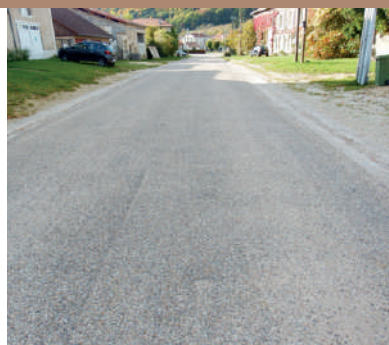
Enduit bicouche : au centre du village
