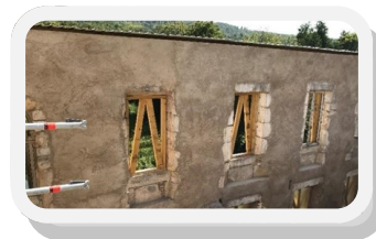
Intérieur façade avant et après travaux
